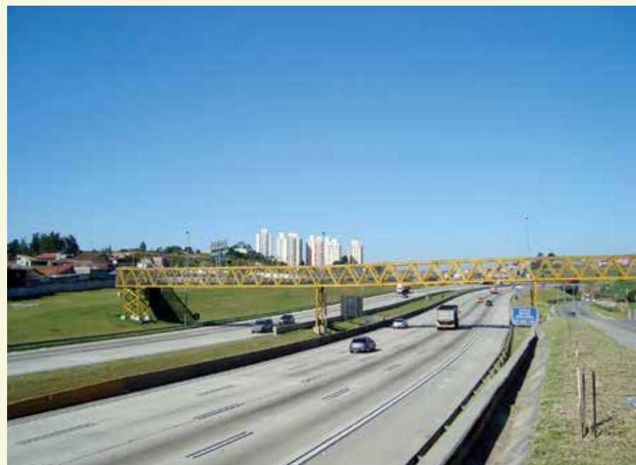
Trecho Oeste do Rodoanel: 32 quilômetros de extensão, cruzando Osasco.
